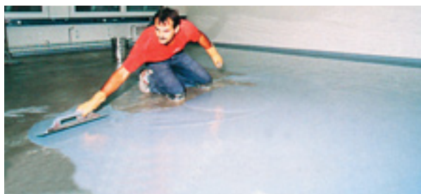
Önterülő anyag felhordása fogazott glettvassal
