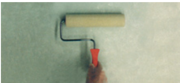
Matt fedőréteg felhordása rövidszálú hengerrel
