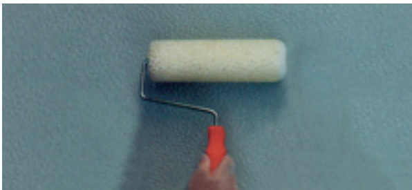
Struktúrált bevonat felhordása stuktúra hengerrel
