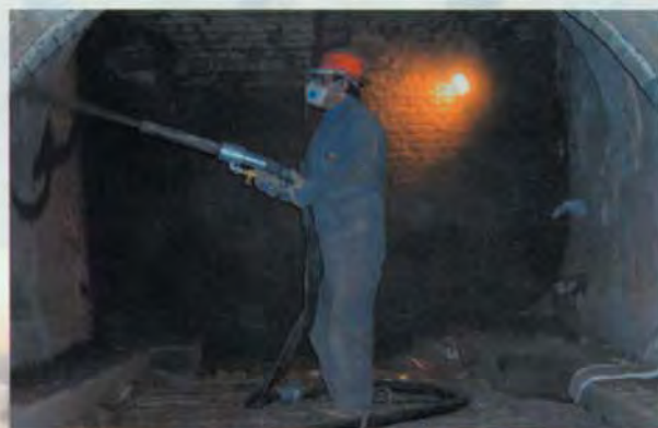
Alagútfal javítási munkálatai
