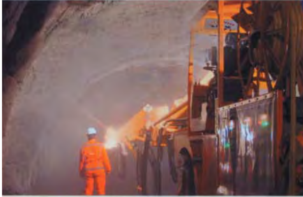
Sika®-PM500 betonlövő rendszer alkalmazása nagyobb szekcióknál
