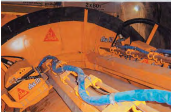
Betonlövő robot egysége az alagútfúró berendezésen, pajzs (TBM)
