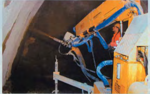
Aliva®-503 betonlövő rendszer alkalmazása kisebb szekciók esetében
