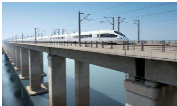
BETONJAVÍTÁS ÉS SZERKEZETMEGERŐSÍTÉS
