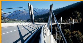
BETONVÉDELEM ÉS HELYREÁLLÍTÁS
