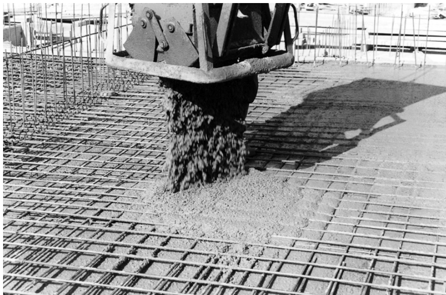
3. fotó: Konténerből történő betonozás
