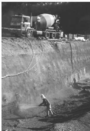
18. fotó: Munkagödör partfal megtámasztása lőtt betonnal
