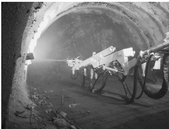
19. fotó: Zárt építési módszerű (NATM) alagút fejtés utáni nedves eljárású lőtt beton biztosítása
